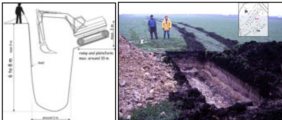
Fig.4 et 5 : Technique particulière de sondage profond dans le but de détecter des gisements préhistoriques et d'identifier des niveaux géologiques (Documents Inrap)
